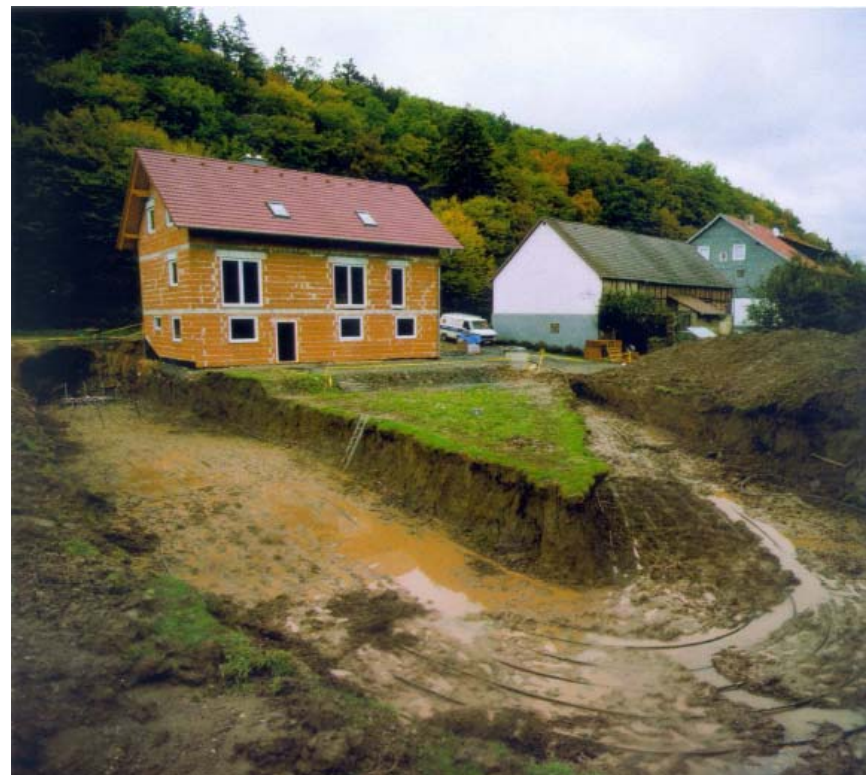
Iskop za podzemni kolektor na dubini od 1.5 m
