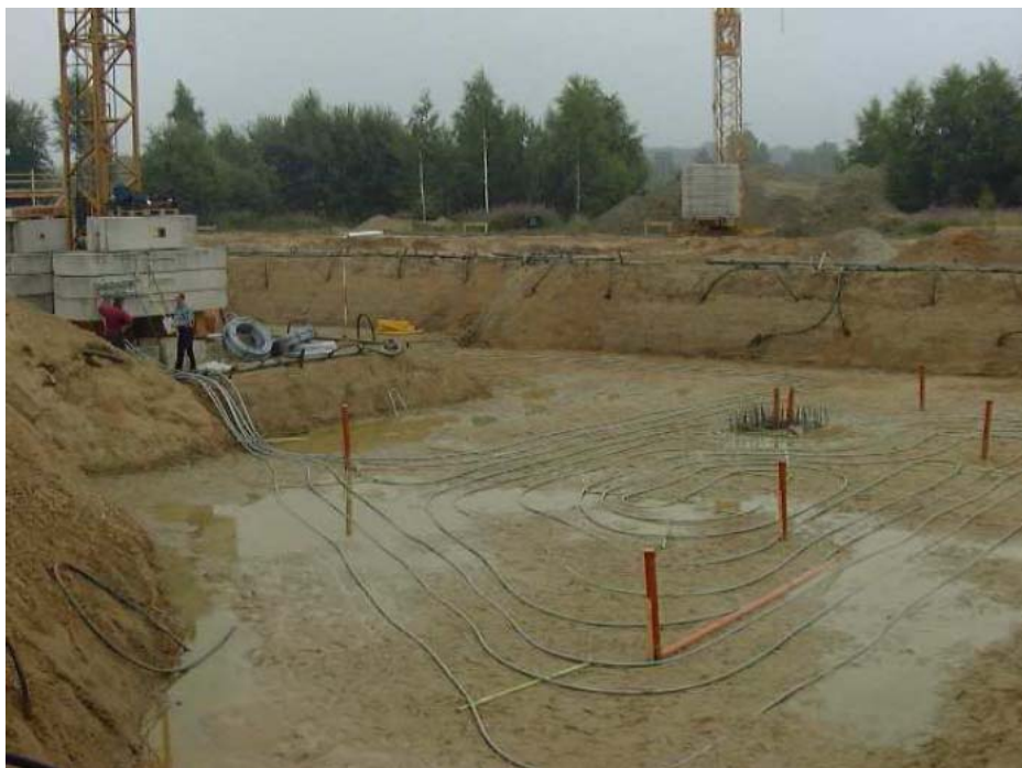
3600m kolektor 32x2.9mm (45kW hlađenje)
