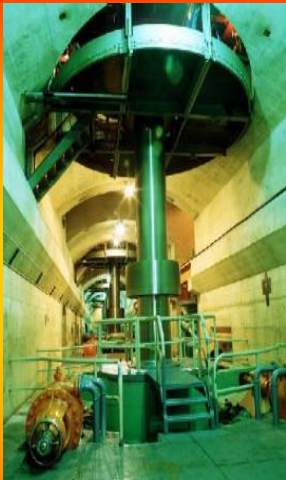
Osovina koja povezuje Generator i transformator
