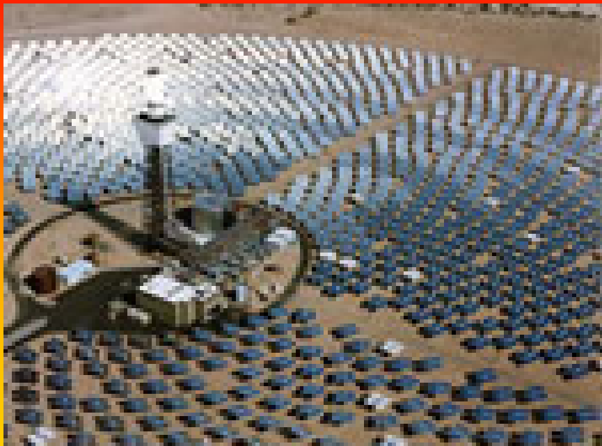
"Power tower" sistem fokusiranja.
